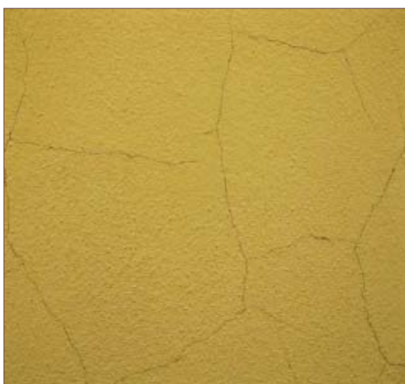
Cavillature a ragnatela con successivo degrado e solubilizzazione dell'intonaco di finitura
