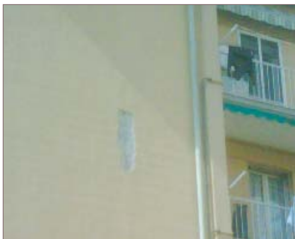
Successivo distacco dell'intonaco in prossimità di una cavillatura
