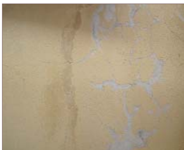
Cavillature a ragnatela con successivo degrado e solubilizzazione dell'intonaco di finitura
