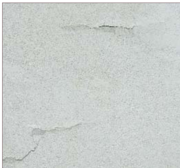
Successivo distacco dell'intonaco in prossimità di una cavillatura
