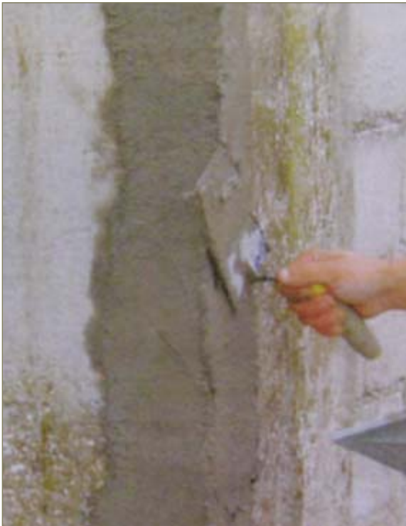
Applicazione della malta tixotropica fibrorinforzata antiritiro
