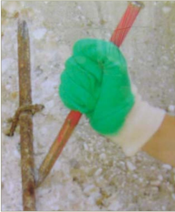
Pulizia dei ferri d'armatura
