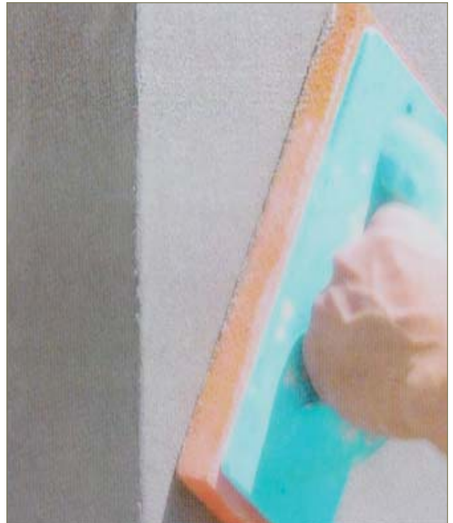
Finitura con stucco cementizio
